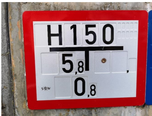
Hinweisschild zum Auffinden eines Hydranten Im Beispiel: 5,8 m nach links, 0,8 m Richtung Betrachter
