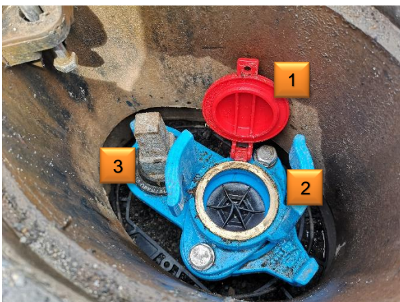
Geöffnete Hydrantenkappe
